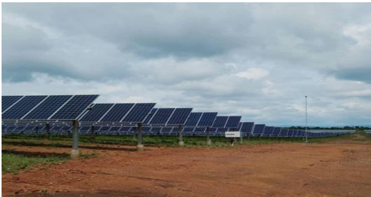
Figure : Centrale solaire SHEIK Mohamed Bin Zayed de Blitta
